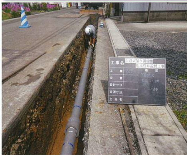
配水管(耐震管)布設替工事の様子
