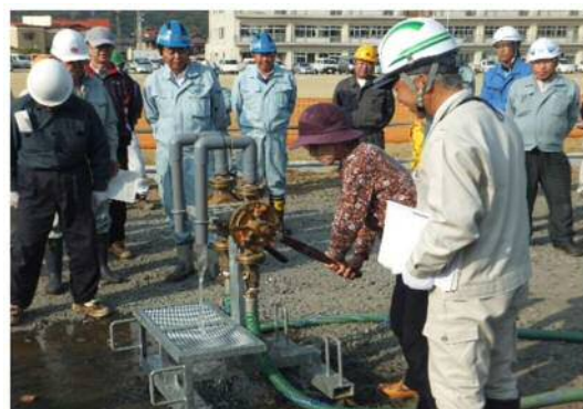
災害応急活動訓練での飲料水兼用耐震性貯水槽からの給水訓練
