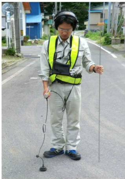
探知機による漏水調査の様子
