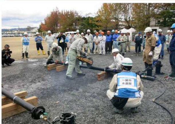
災害応急活動訓練での、水道工事業者による復旧工事訓練の様子
