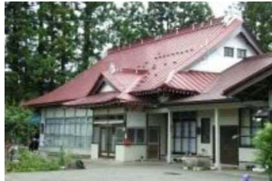
伝統的な様式を継承している農家建築は多い
