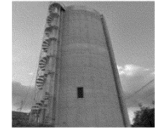
耐震性を強化した沢配水池
