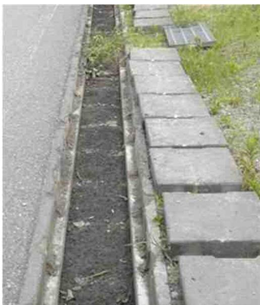
側溝に堆積した土砂
