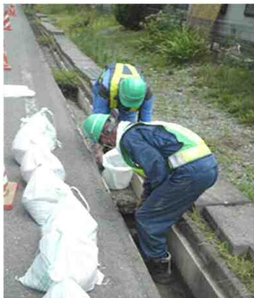
側溝土砂の除去作業
