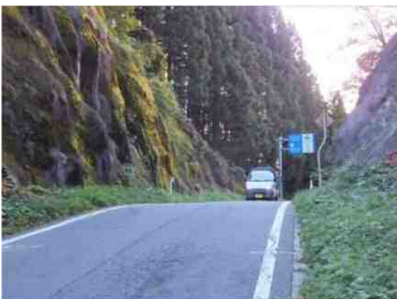
国道456号線：宮城県境付近七曲峠
