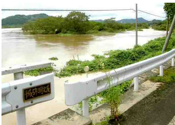
平成 19 年 9 月秋雨豪雨被害 (黄海川洪水 藤沢町黄海地区)
