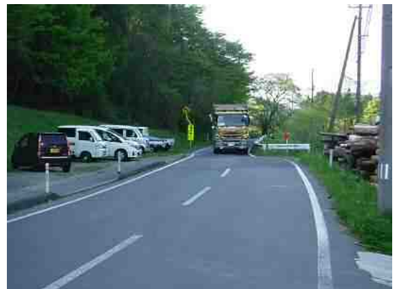
本吉室根線：室根町津谷川本宿地区
