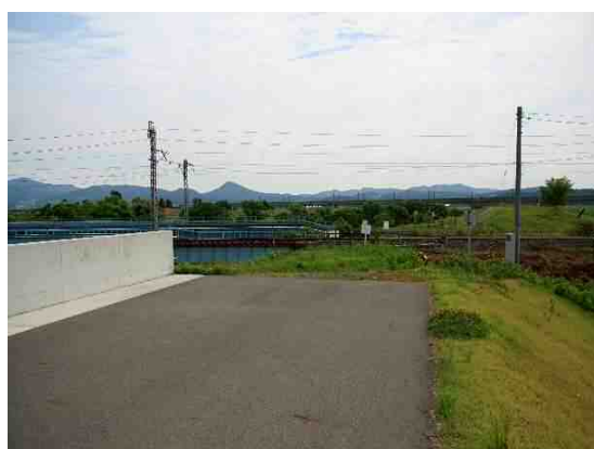
線路で遮られた磐井川堤防の管理用通路 平成 29 年 6 月
