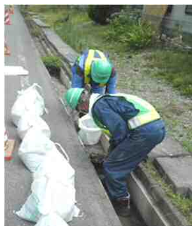
側溝土砂の除去作業 (緊急対応分)
