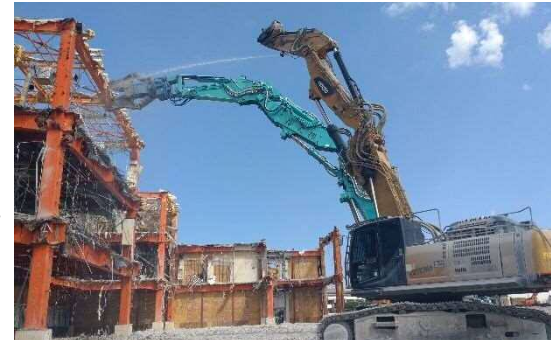
【大型重機による散水】
