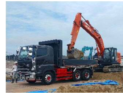
【汚染土壌の掘削除去】
