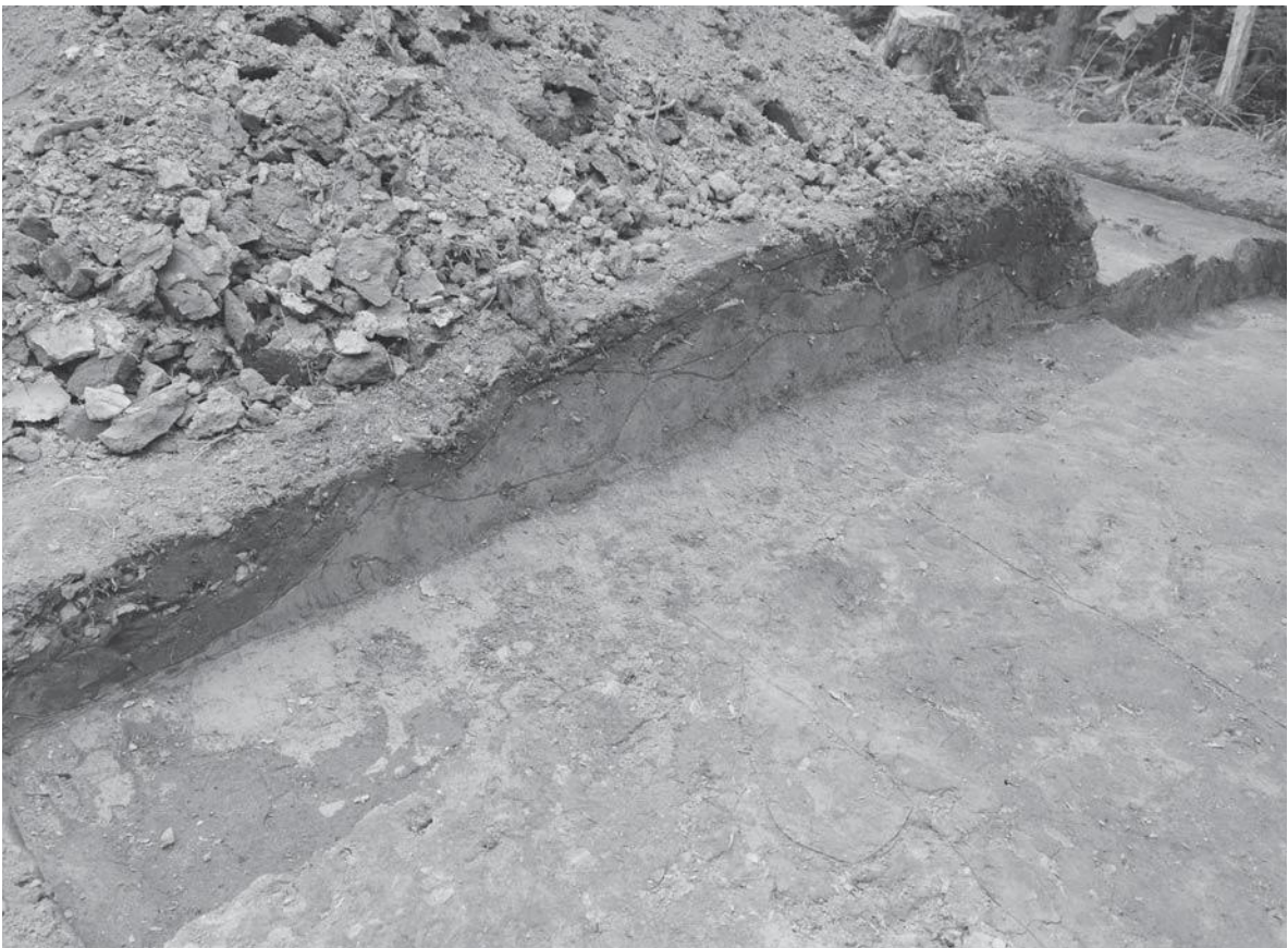
2 1トレンチ道路遺構1図4-AA'(南東から)
