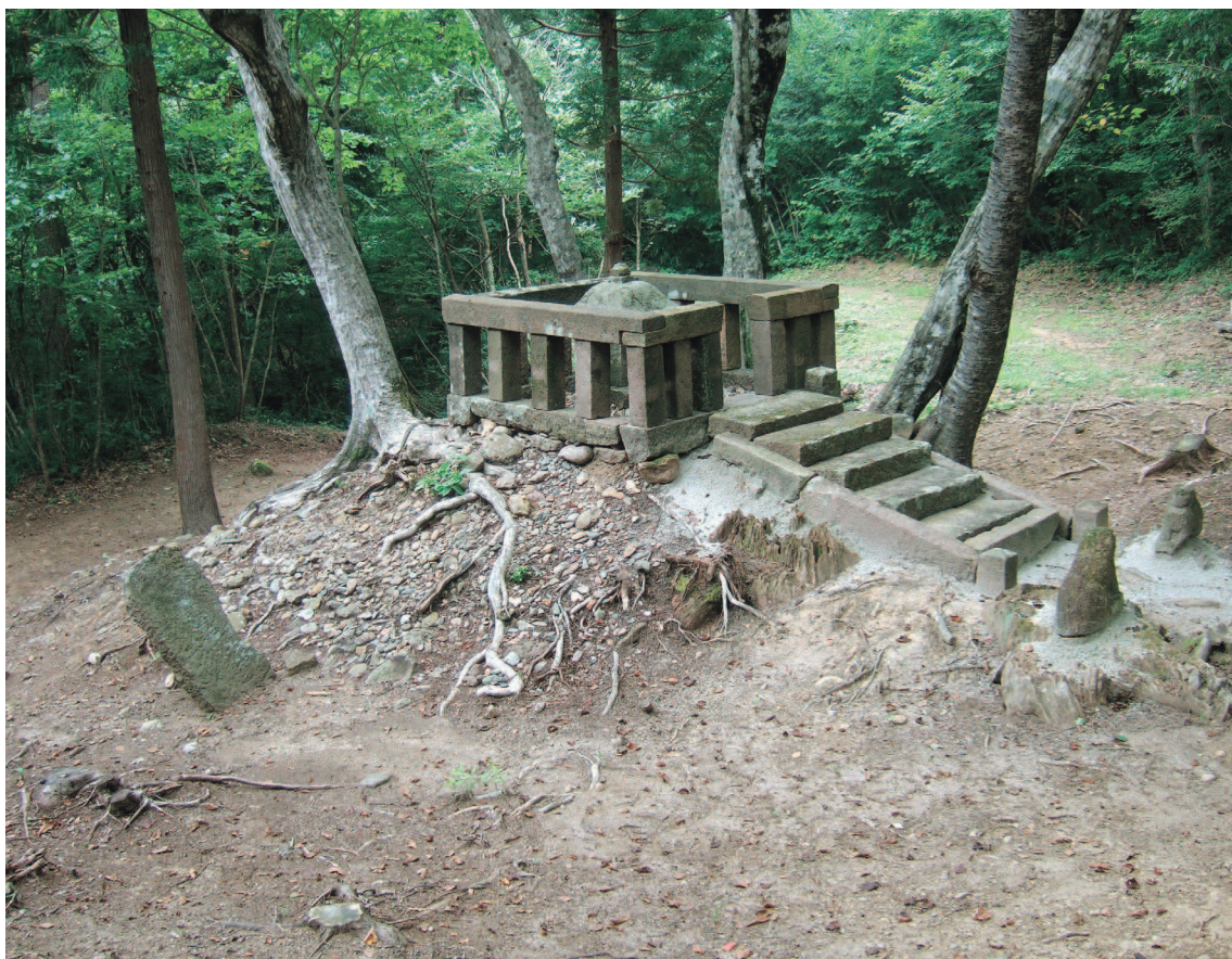
石材復旧された慈恵塚（南東から）
