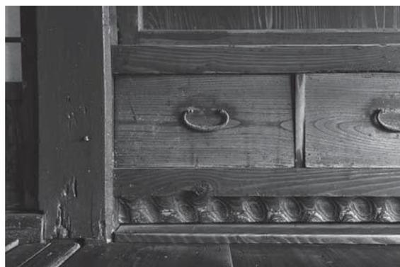
図8 引出し下方の雑面仕上げによる蹴込板
