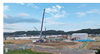
建物の解体が進むNEC跡地
