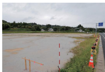
道の駅の建設予定地
