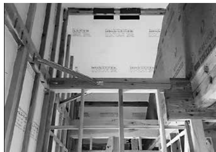
省エネ対策の断熱工事
