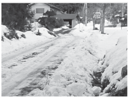
側溝の整備が待たれる市道
