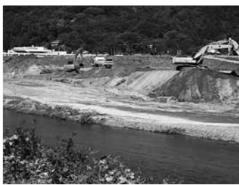
砂鉄川河道掘削工事
