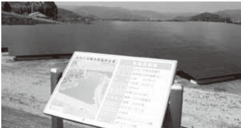
群馬県太田市「おおた太陽光発電所」
