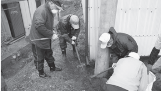
住民参加で除染作業（雨どい付近の土をとり除く）
