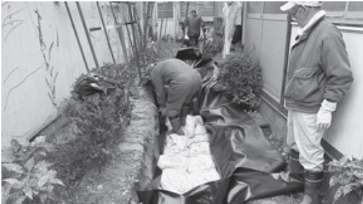
住民参加で除染作業（除染土を埋設）
