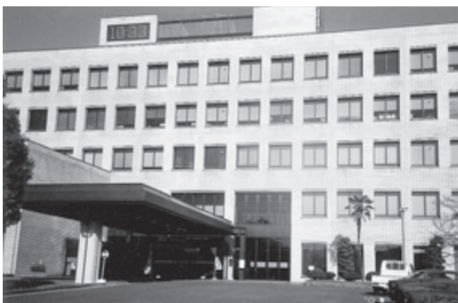
一関市役所本庁舎
