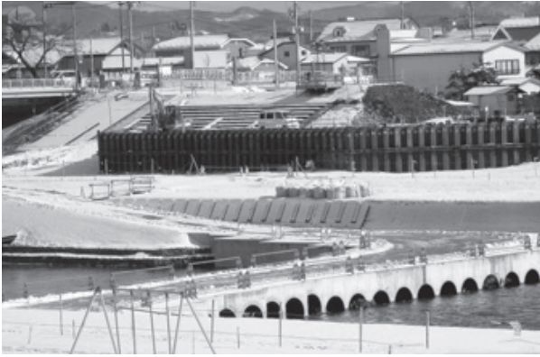
堤防改修工事に伴う仮橋
