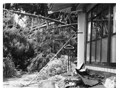
地震で倒れ、土台下を突き抜けた立ち木
