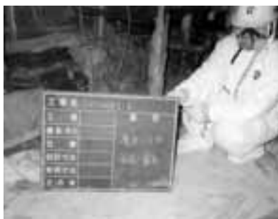
撤去されたアスベスト
