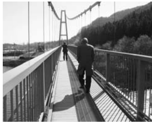
もみじ谷大吊橋（那須塩原市）
