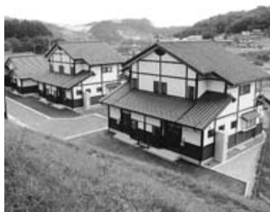
一部完成した山谷住宅（東山地域）
