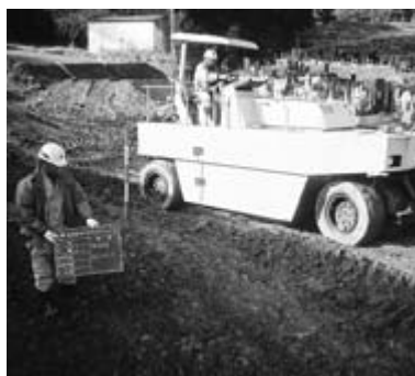
道路建設現場
