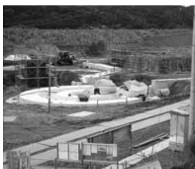
建設中の川崎浄化センター
