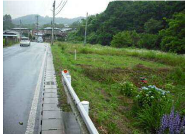
現況写真 北方向
