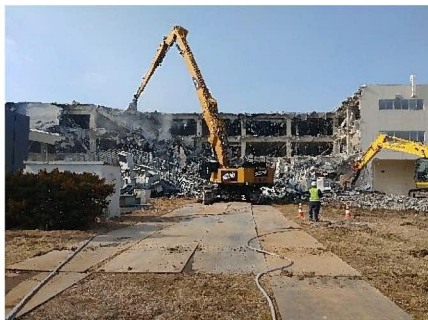
【上屋解体状況】
