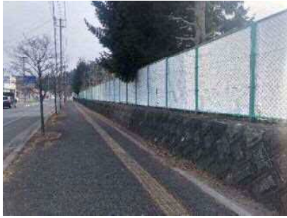
【シートによる仮囲い】
