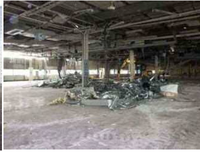
【内装解体状況】
