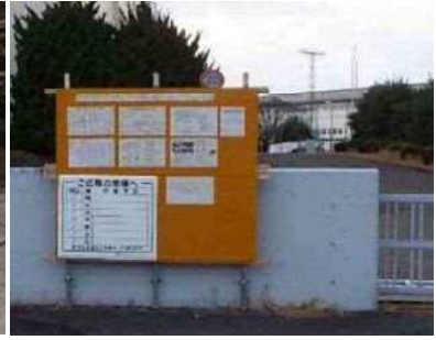
【工事のお知らせ看板（正門前）】
