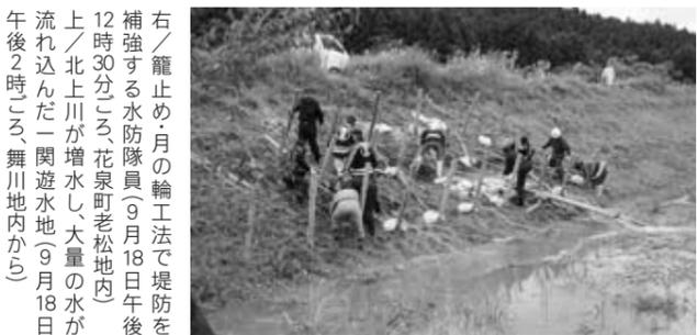
右ノ籠止め月の輪工法で堤防を補強する水防隊員(9月18日午後12時30分ごろ、花泉町老松地内) 上ノ北上川が増水し、大量の水が流れ込んだ一関遊水地(9月18日午後2時ごろ、舞川地内から)
