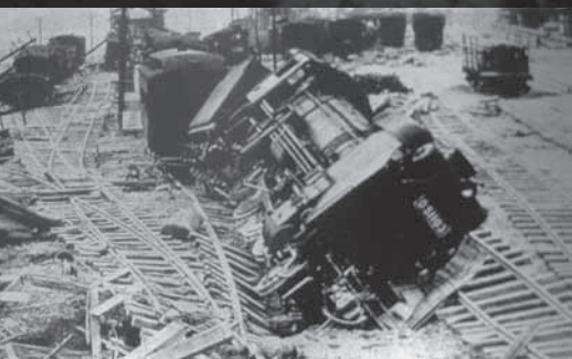
横転したD51機関車。水流で地面もゆがむ
