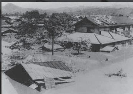
五十人町付近。屋根の上にはふとんが敷かれている
