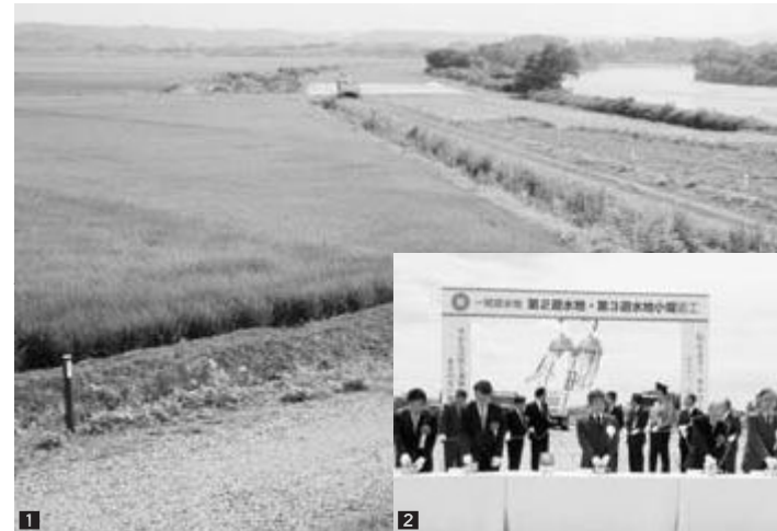
1 舞川揚水機場から第3遊水地を望む。右側を流れる北上川の両岸に堤防が整備されます 2 くす玉開披などが行われた着工式
