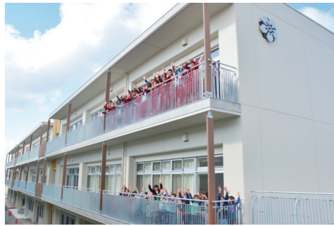
3月に完成した山目小学校の新校舎
