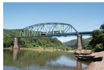
JR 大船渡線北上川橋梁(通称:横石鉄橋)。全長119.5m。この鉄橋は大正14年に建造され、老朽化に伴い昭和53年に架け替え工事が行われました。工事は、古い鉄橋のそばに新しい鉄橋を組み立て、古い橋と一緒に新しい鉄橋を横にスライドさせて切り替える方法で行われ、重さ約317トンの橋は約一時間で架け替えが完了しました。
