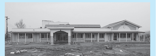
新永井公民館の外観(3.18撮影)
