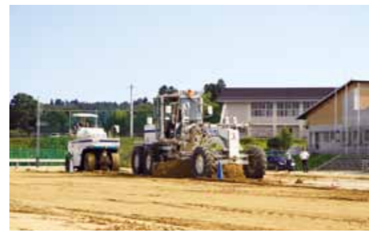
空間放射線量の高い学校の校庭などを除染した
