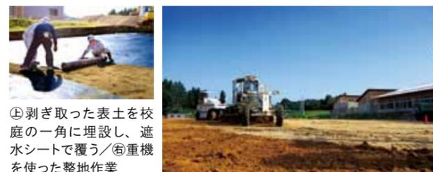
除染方法は、国のガイドラインに沿い、①重機で校・園庭の表土を5センチ剥ぎ取る②剥ぎ取った表土を深さ1.6メートルの穴に埋設する③遮水シートで覆い、その上に掘削した下層の土を30センチ盛って遮蔽する④校・園庭全体を5センチの山砂で整地する。5月22日の新沼保育園を皮切りに始まった作業は8月5日現在、幼稚園2園、保育園5園の7施設で工事が完了。ほとんどの施設で夏休み中の工事完了を目指しています。
