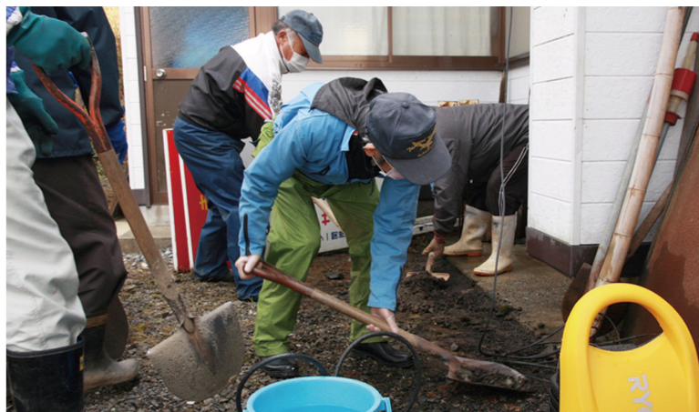
市内舞川で行われた自治集会所の低減対策作業
