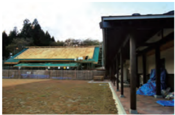
2012年度の完成を目指し、工事が進む展示棟(奥)。隣接する「若神子亭」と共に骨寺村の歴史、景観や文化を伝える
