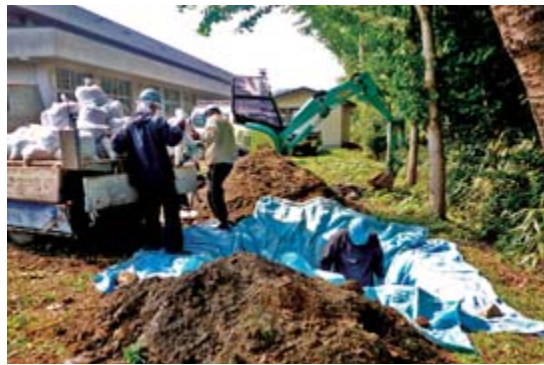
上：除去した土砂を埋めるための穴掘り作業 右：除去した土砂をまとめて埋める低減対策
