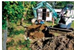
上：除去した土砂を埋めるための穴掘り作業 右：除去した土砂をまとめて埋める低減対策
