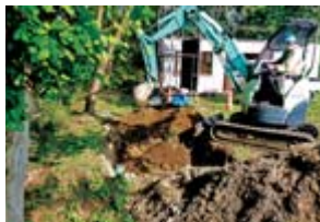
上：除去した土砂を埋めるための穴掘り作業 右：除去した土砂をまとめて埋める低減対策
