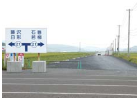
整備が進む国道342号花泉バイパス
