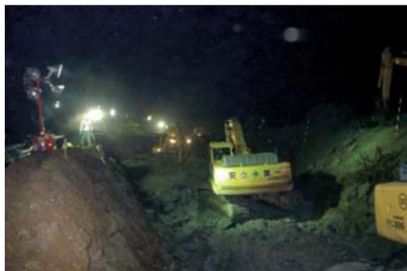
24時間体制で進められた市野々原地内の磐井川土砂ダム仮排水路工事（写真提供：宇部建設）
