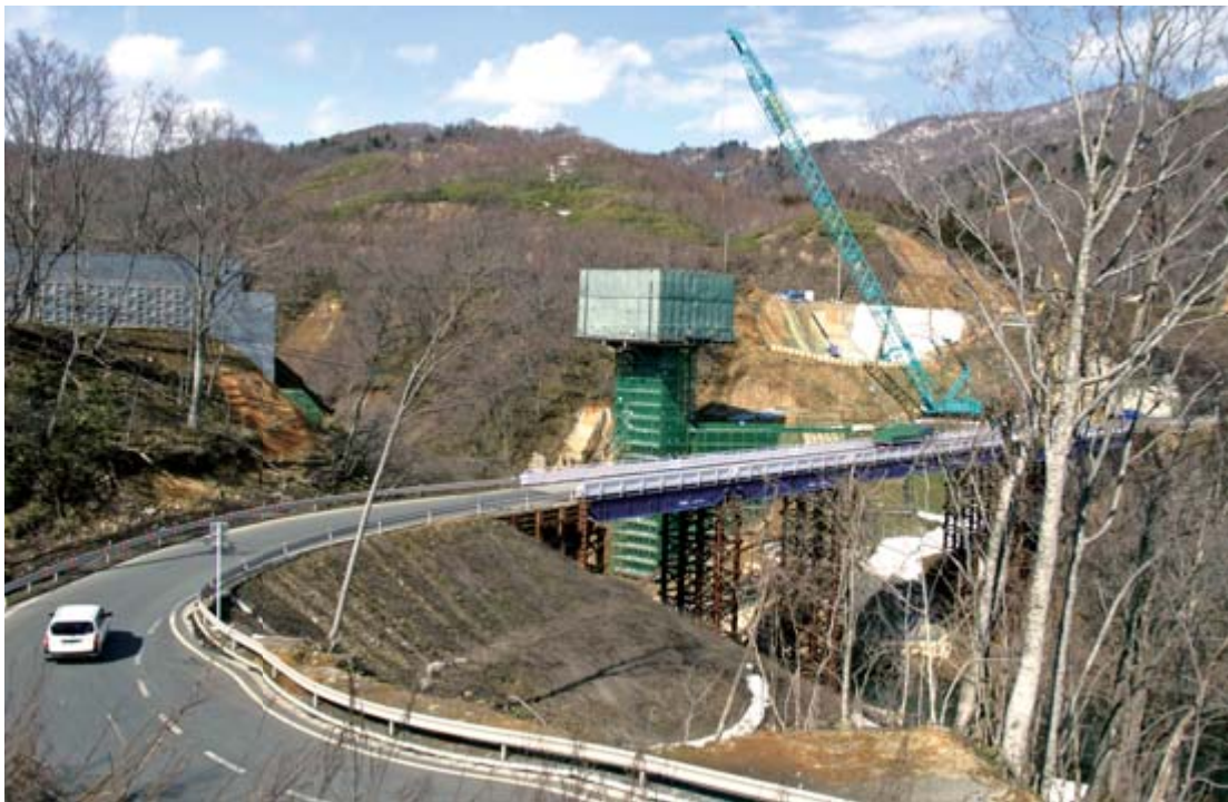
中央を横切るのが20年11月開通した国道342号祭時大橋仮橋。その傍らで、新設する橋の工事が盛んに進められています
