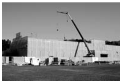
22年春の開校に向け建設中の統合大原小学校舎
