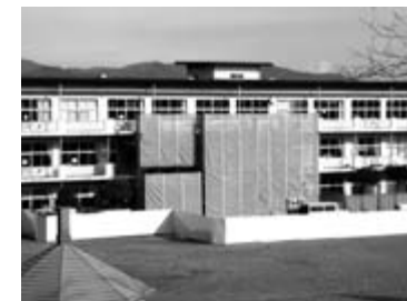
中里小校舎耐震補強工事
