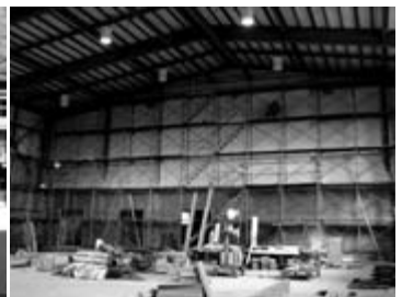
東山中屋内運動場改築工事
