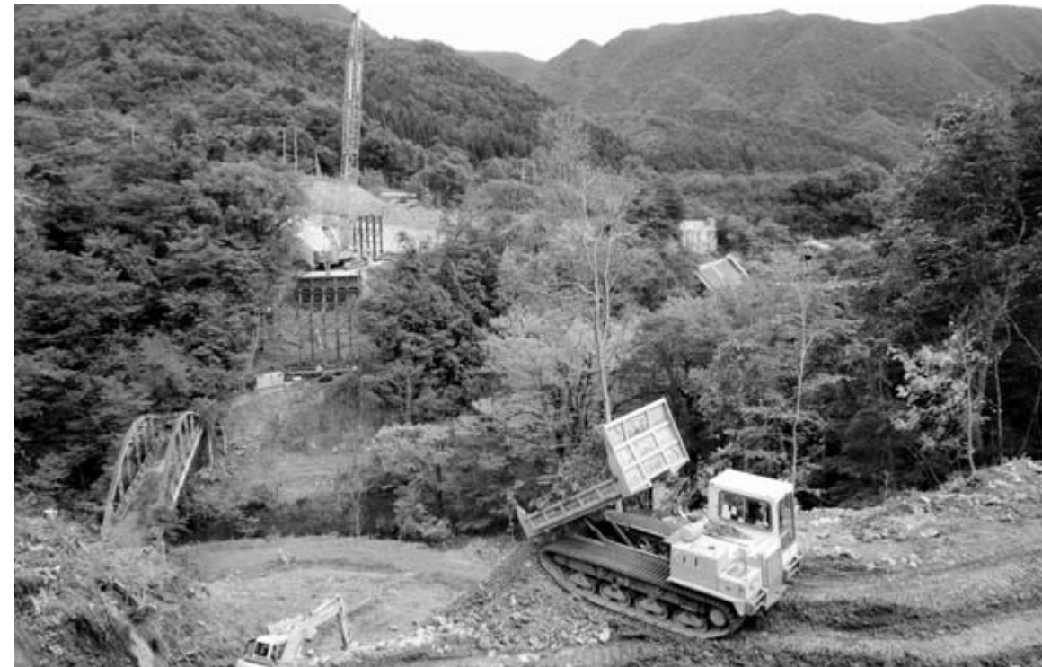
降雪期前の完成を目指して県が急ピッチで整備を進めている、国道342号祭時地区への仮橋
