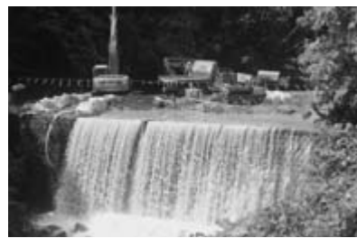
▲産女川砂防ダムの復旧工事(7月2日)
