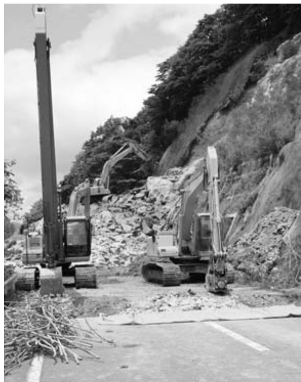
▲市野々原地内国道342号で急ピッチで進む復旧工事(6月27日)
