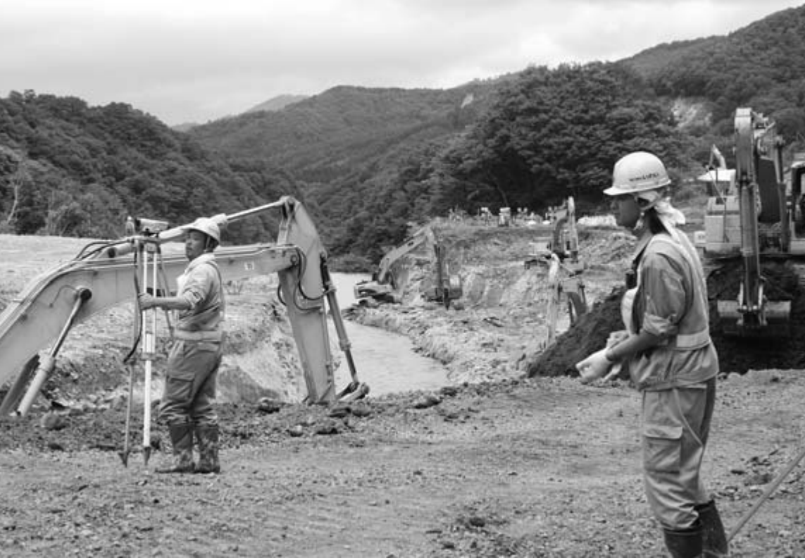
▲ 大量の土砂が磐井川をせき止めた市野々原地内。右は上流の市野々原砂防ダム(6月14日) ◀ 同土砂ダムでは18日から24時間体制で仮排水路の開削工事が行われ、21日から排水開始。引き続き水路の断面拡大の工事が行われました(6月27日)
